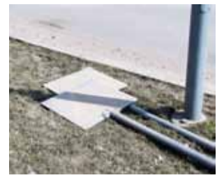
Pölyä riittää louhintatyömaalla.
