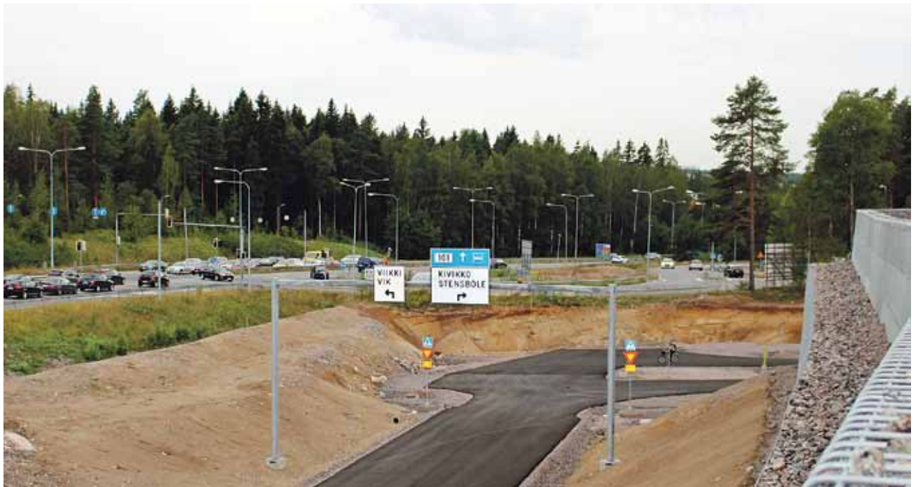
Kivikon eritasoliittymän 1. vaihe on jo valmistunut. Viitta Viikkiin on jo paikoillaan!
